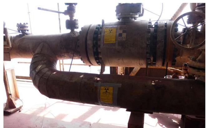
**Gambar 2:** Area kontaminasi TENORM pada pipa
